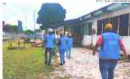
A obra está sendo finalizada pela Secretaria de Infraestrutura.
